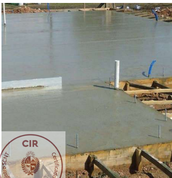
Detalle de colocación de fijación de perimetral inferior (solera) a platea
