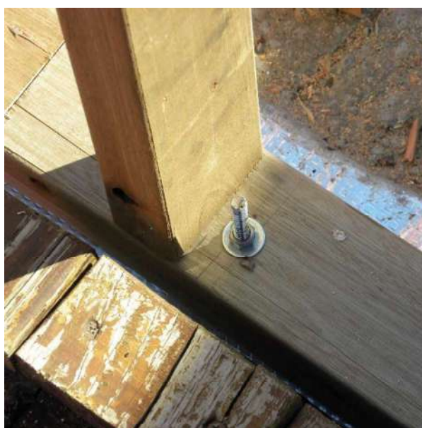
Detalle de colocación de fijación de perimetral inferior (solera) a platea
